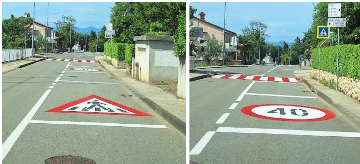
Primjeri izvedenih oznaka na kolniku (ŽC5084, Njivice) – načelni izgled
