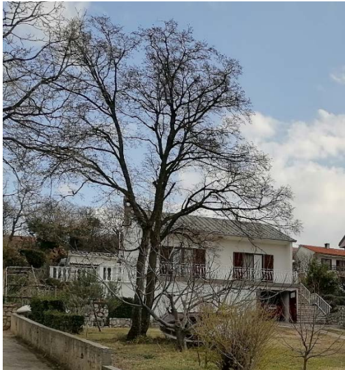
- postojeće stambene građevine tip 2
