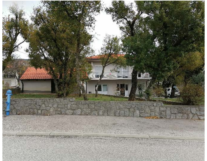
- postojeće stambene građevine tip 2
