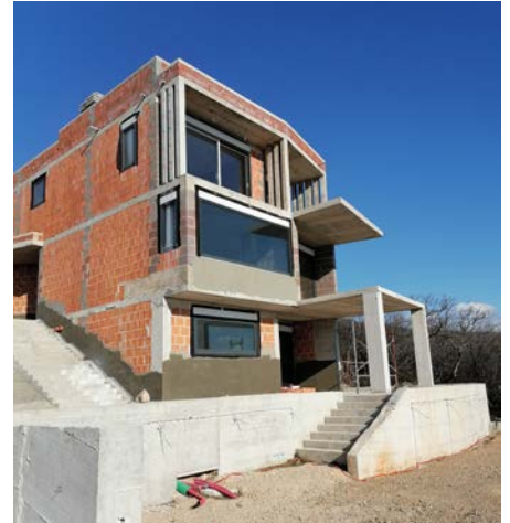
- postojeće stambene građevine tip 3
