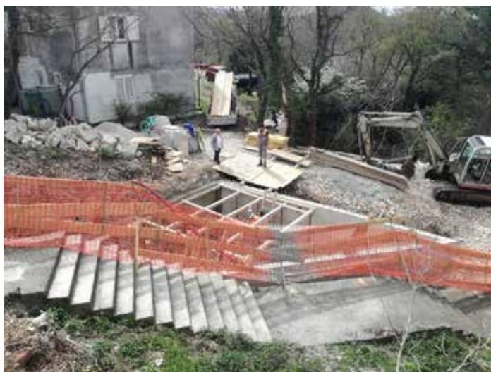
U mjesecu lipnju dovršena je izgradnja upojnog bunara za oborinske vode u ulici Kalina u Kraljevici. Upojni bunar dio je novoizgrađenog sustava odvodnje u velikom zavodu ulice Kalina, te je projektiran za prihvat 60m<sup>3</sup> vode. Između ostalog, namjena mu je i sprječavanje poplava u ulici Carovo i Randićeva. Izvođač radova bio je Kvarner Graditeljstvo d.o.o.
