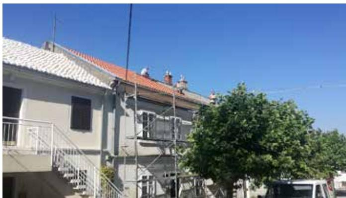
Na krovu Doma u Bakaracu sanirana je šteta od jakog nevremena koje je ove zime odnijela dio krovnog pokrova-salonitki. Zamijenjeno je cca 100m<sup>2</sup> krova s postavom crijeva mediteran i izradom potrebnih limenih spojeva. Izvođač radova bio je Ri-profil d.o.o. iz Šmrike.
