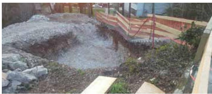
Grad je ugovorio sa najpovoljnijim ponuditeljem izgradnju **upojnog bunara na zavodu u Kalini** kojim će se postojeći upojni bunar ukloniti te će se izraditi novi, veći. Ovime će bolje biti riješena odvodnja oborinske vode sa ceste. Vrijednost ovih ugovorenih radova je 134.143,75 kn.
